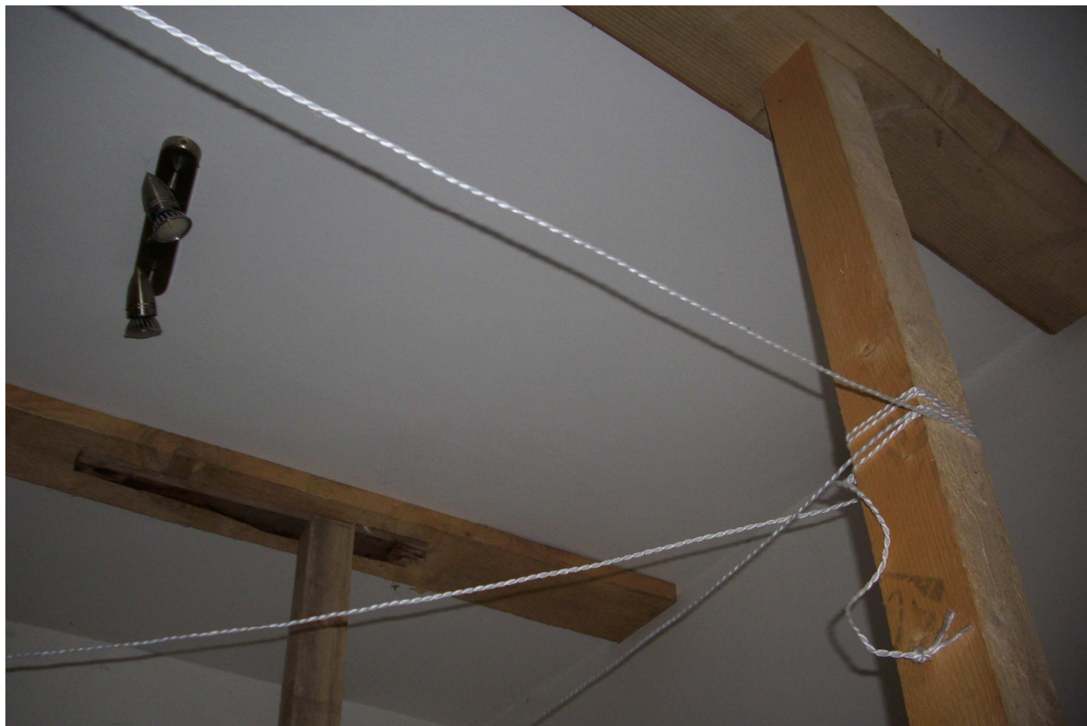
Zdjęcie nr 5 – stemple w kuchni mieszkania nr 11 na parterze
