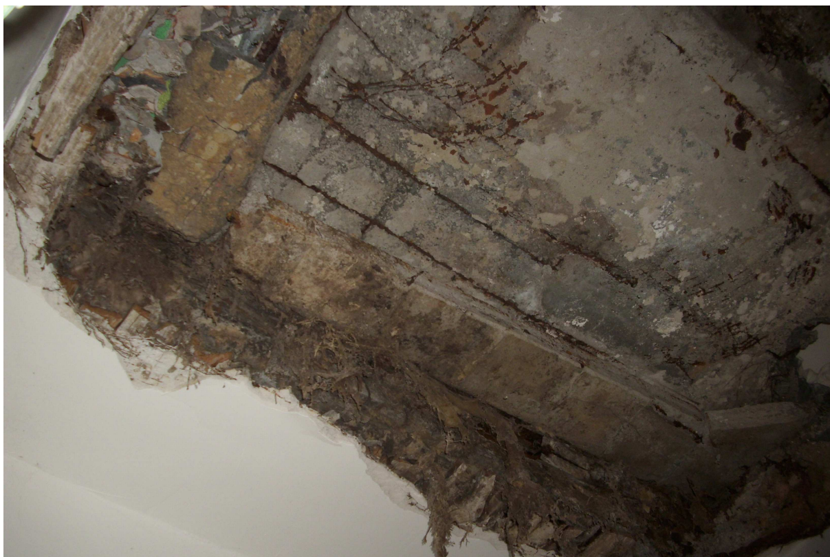
Zdjęcie nr 8 – zniszczony strop nad WC w mieszkaniu nr 11 od strony pokoju
