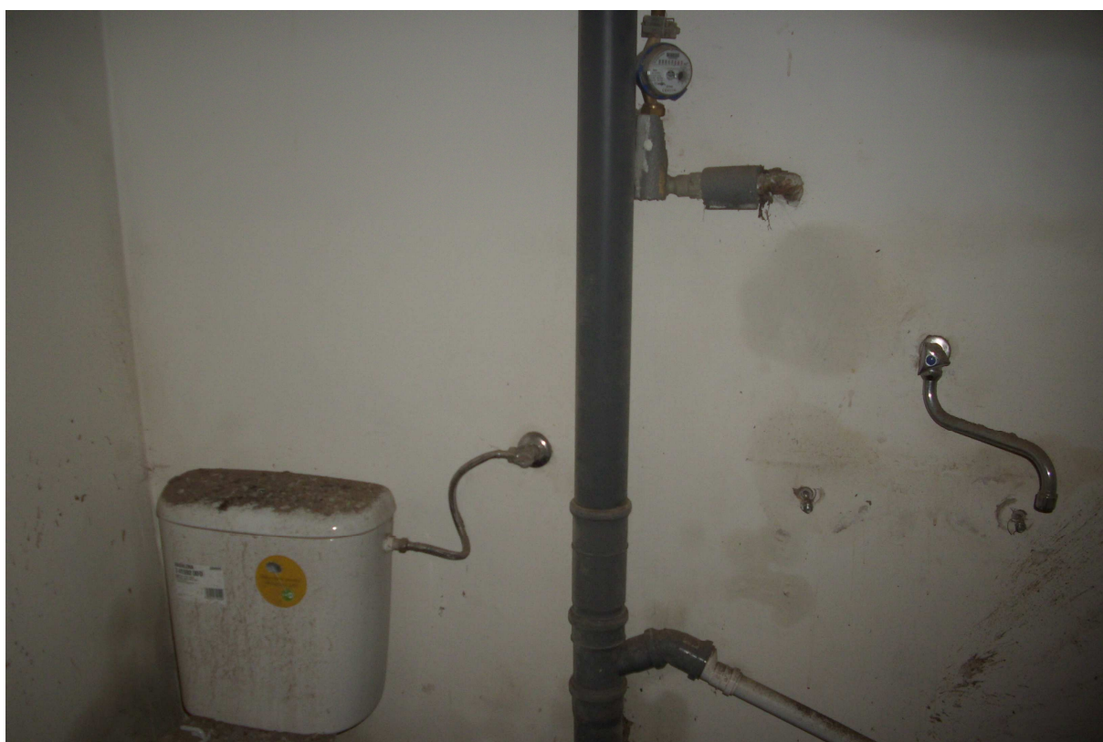
Zdjęcie nr 6 – zniszczona ubikacja po upadku stropu w mieszkaniu nr 11 na parterze
