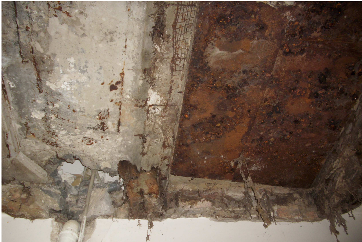
Zdjęcie nr 7 – zniszczony strop nad ubikacją w mieszkaniu nr 11 od strony klatki schodowej
