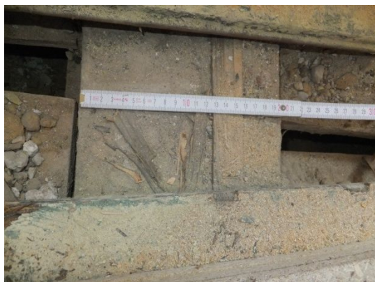
Rys 1. Przekrój poprzeczny przez strop
